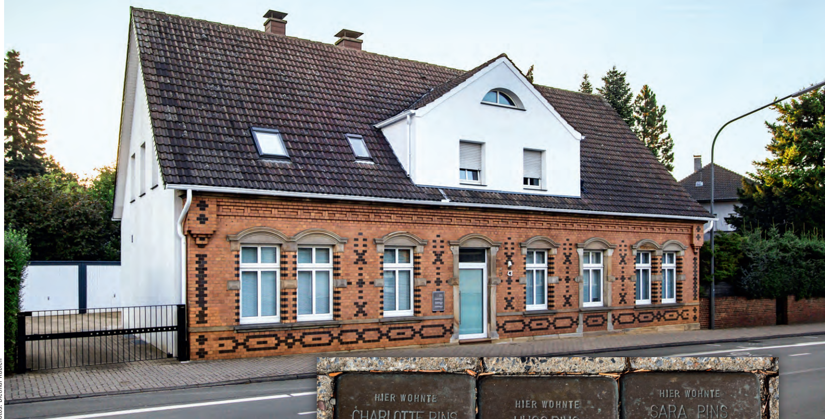
Das ehemalige sogenannte „Judenhaus“ in der Coesfelder Straße 43 in Dülmen.
